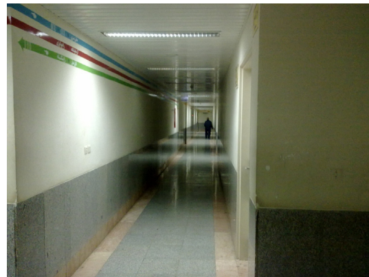
شکل ۵: راهروی باریک و طولانی با سقف کوتاه، که در هنگام تخلیه اضطراری می‌تواند مشکلاتی را ایجاد کند.
