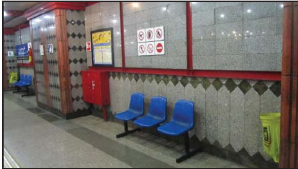
شکل ۸. جانمایی عناصر غیرسازه‌ای در عقب‌نشینی دیواره تراز سکوی ایستگاه امام خمینی (ره)
