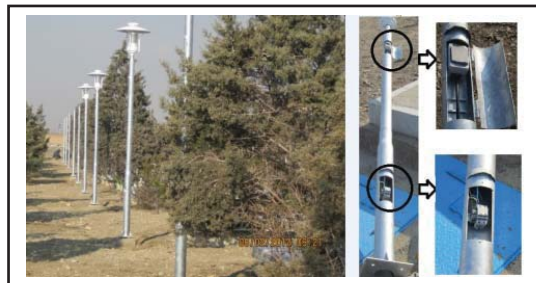
سیستم برق‌رسانی، چراغ و پایه چراغ
