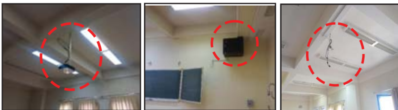
تصویر ۱۱: محکم کردن اتصال پروژکتور و تأسیسات مورد استفاده در کلاس درس و نمایش سیم‌های آویزان. منبع: نگارندگان
