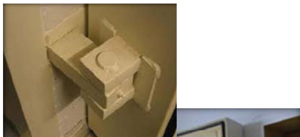
شکل ۱۰- در و لولای استفاده شده در پناهگاه هسته‌ای سوئیس*
