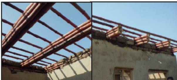
تصویر ۶. نحوه اجرای سقف‌ها با چوب بامبو (سازمان بین‌المللی مهاجرت، ۲۰۱۲، ص ۳)
