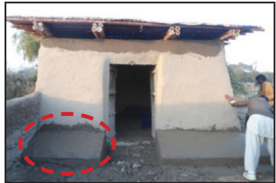
تصویر ۸: سطح کف بالا آمده یا پاستون (سازمان بین‌المللی مهاجرت، ۲۰۱۲، ص ۳۳) بازترسیم: نگارنده
