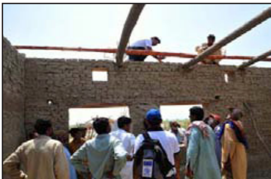
تصویر ۱۲. نمونه‌ای از ساخت سرپناه آجری (سازمان بین‌المللی مهاجرت، ۲۰۱۲، ص ۳۳)
