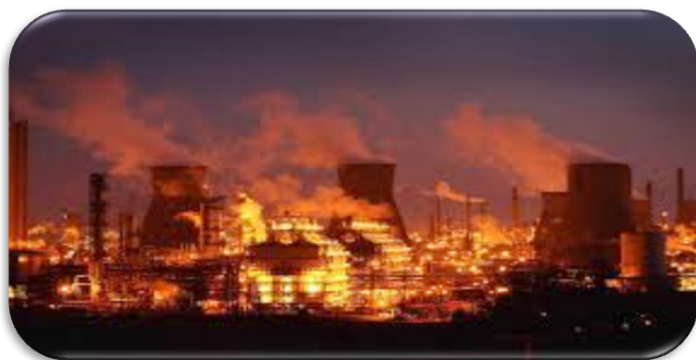
شکل ۵: نمونه ای از حریق در نیروگاه
