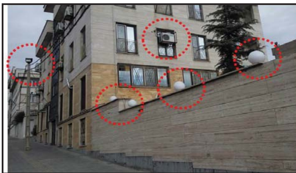
تصویر ۲۰: امکان سقوط برخی از اجزای غیرسازه‌ای
