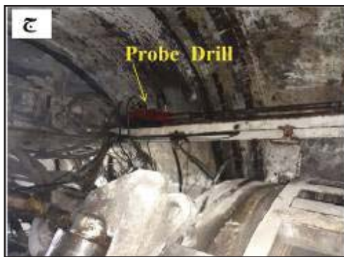
شکل ۲۵: الف: تعبیه حفره در نیمکره پایین سپر. ب: نصب لوله‌های هادی بر روی حفره‌ها. ج: دستگاه حفاری گمانه پیشرو.
