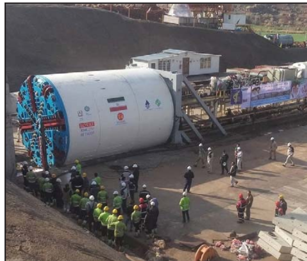
شکل ۱۵: ماشین حفار در پروژه تونل سرپل‌ذهاب.
