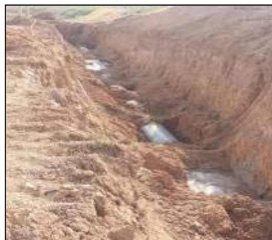
شکل ۲۰: گذاشتن لوله در کانال، احداث دایک در بالادست رودخانه و انحراف آب رودخانه به داخل لوله.
