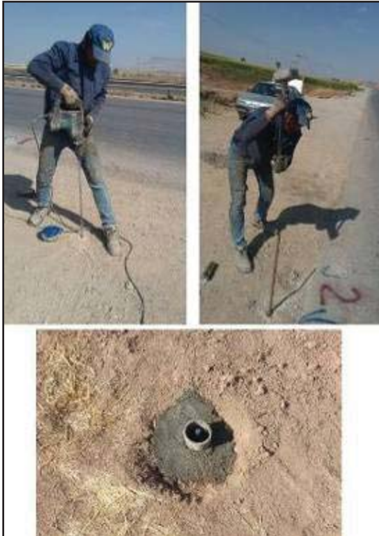
شکل ۲۲. ابزار بندی جهت کنترل نشست در محدوده جاده ارتباطی شهر سرپل‌ذهاب و قصر شیرین.
