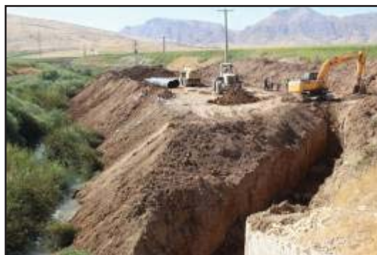
شکل ۱۹. حفر کانال و قرار دادن لوله در آن جهت عبور آب از داخل آن.
