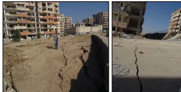
شکل ۷: تصاویری از شکاف‌های ایجاد شده در اثر پدیده گسترش جانبی ناشی از پدیده روانگرایی در محدوده مجتمع مسکن مهر شهید شیروودی (حق‌شناس و همکاران، ۱۳۹۶-الف).
