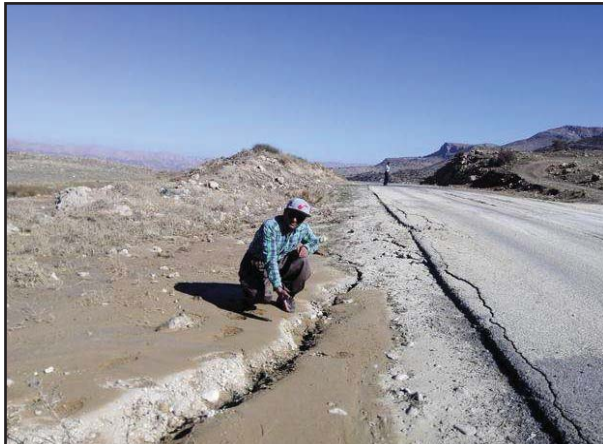
شکل ۸: آسیب دیدن بدنه راه بر اثر روانگرایی و جوشش ماسه در محور تازه‌آباد - سرپل‌ذهاب (بسطامی و همکاران، ۱۳۹۶).
