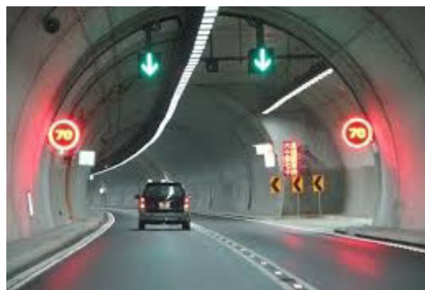
تصویر ۸: تونل سوئیشن، منبع: پروژه زیباسازی زیرگذر، ۱۳۹۰
