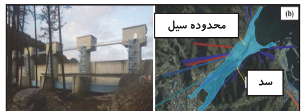
تصویر ۹: سد ساخته شده به ارتفاع ۱۱ متر در روستای فودائی در توهوکو ژاپن، منبع: (ساپارسی و همکاران، ۲۰۱۲، ص. ۲۶)
