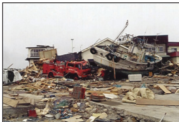
تصویر ۲: تخریبی که توسط اثرات آوار و نخاله های ناشی از سونامی ۲۰۱۱ در شهر آونایی ژاپن به یکی از ساختمان ها وارد شد. (هینتز و ماهونی ۲۰۰۸، ۶۴۶، ص. ۱۹)
