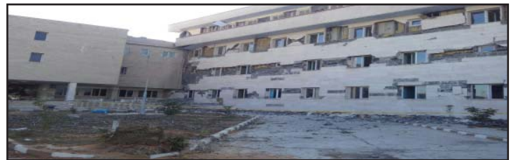
شکل ۳. بیمارستان امام خمینی اسلام آباد غرب پس از وقوع زلزله ۷.۳ ریشتری (امینی حسینی و همکاران، فصل پانزدهم، ۱۳۹۶).
