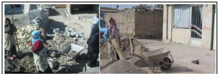
تصویر ۱: مشارکت زنان در فعالیتهای بازسازی زلزله‌ی ورزقان (گزارش چهارم بنیاد مسکن، ۲۰۱۲).
