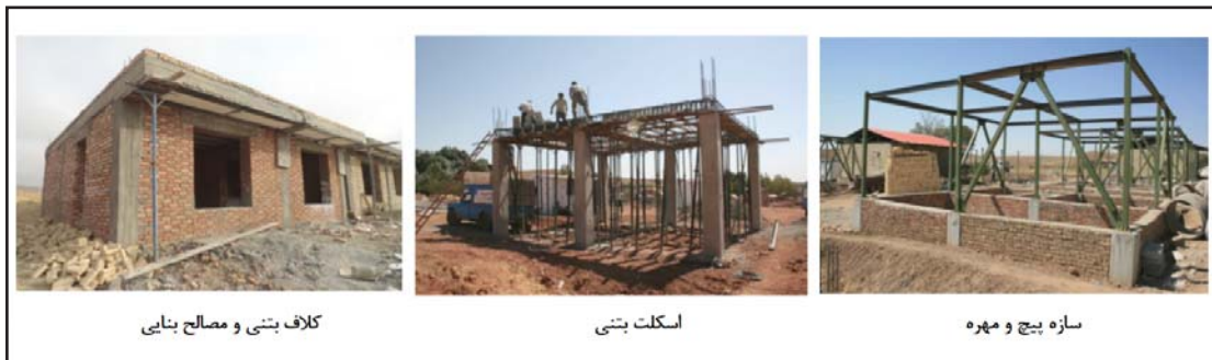
تصویر ۳: نمونه‌ای از سازه‌های مورد استفاده در بازسازی زلزله‌ی ورزقان، (فلاحی، ۲۰۱۳)
