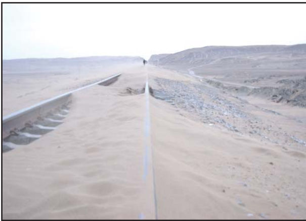
شکل ۱: هجوم ماسه‌های روان به خط ریلی در بلاک تل‌حمید - منتظر قائم محور شرق راه‌آهن کشور (نگارندگان ۱۳۹۵)
