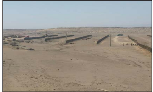
شکل ۴: احداث دیوار با تراورس‌های چوبی - ایستگاه تل حمید در محور شرق راه آهن ج.ا.ا. (نگارندگان ۱۳۹۵)
