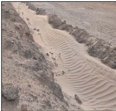
شکل ۳: تله رسوب گیر - ایستگاه تل حمید در محور شرق راه آهن ج.ا.ا. (نگارندگان ۱۳۹۵)
